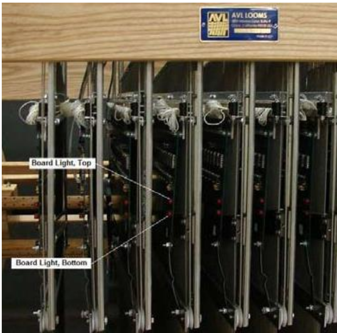
Figura 104 - Módulos, vista frontal que muestran luces de tablero
