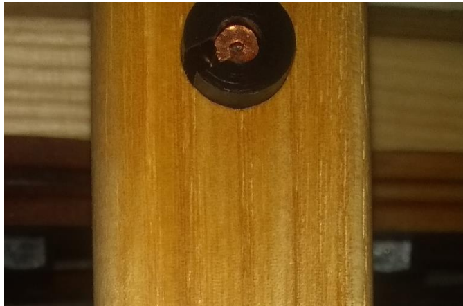
Abbildung 9 - Nico mit Kabelknopf gesichert
