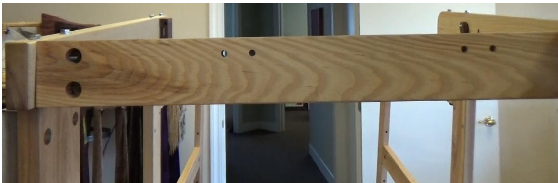
Figura 25 - Fijación del travesaño delantero
