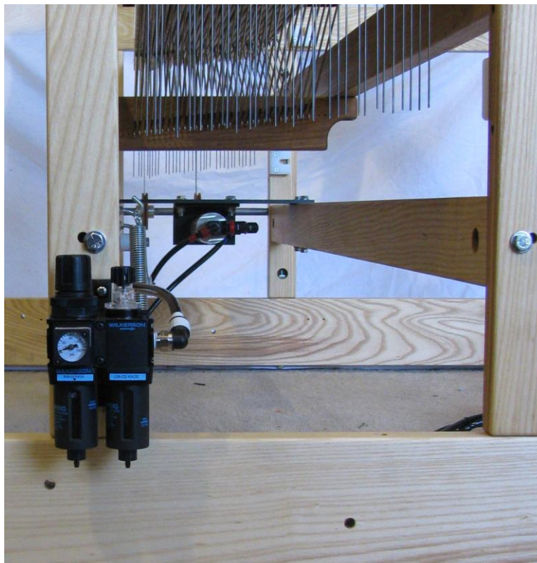
Figura 135 - Colocación de FRL
