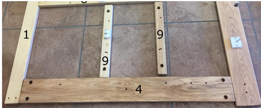
Figure 17 - Cadre latéral partiellement terminé
