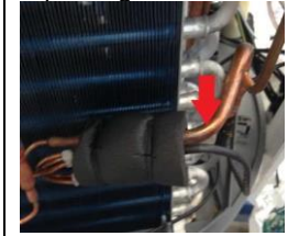
Hőelem pozíciója Elpárologtató érzékelő
