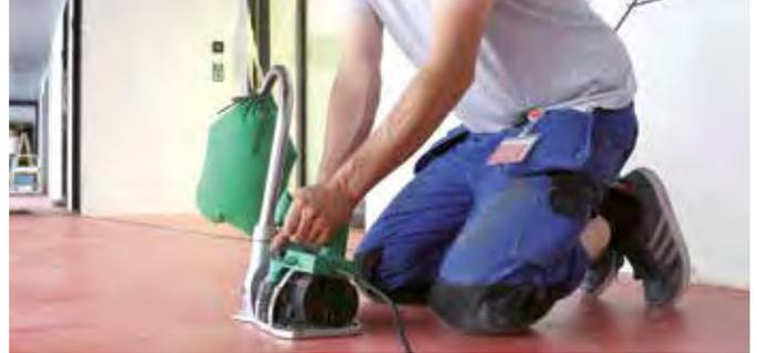
Der kräftige Antrieb ist für PVC-, PUR- und Linoleum-Material geeignet.
