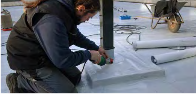
Handschweissen mit Kunststoff Dichtungsbahnen.
