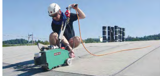
Der BITUMAT B2 schweisst Elastomerbitumen flammenlos.
