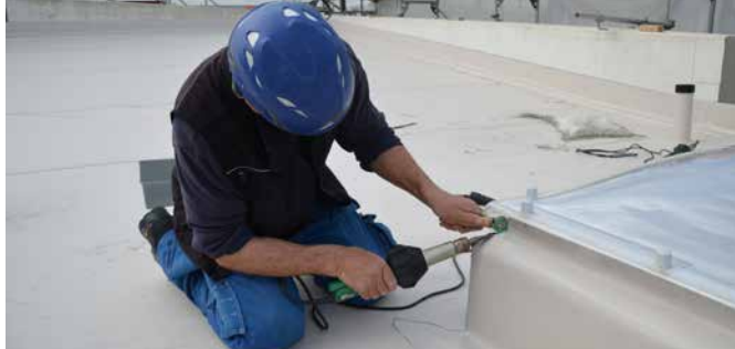
Detailarbeit an der Lichtkuppel.
