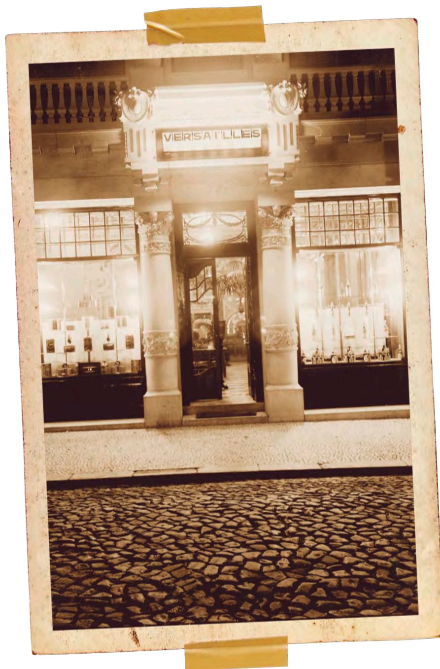
FOTOGRAFIA SEM DATA DA FACHADA DA PASTELARIA VERSAILLES, DA AUTORIA DO FOTÓGRAFO MÁRIO NOVAIS (1899-1967). EM CIMA E À DIREITA, @ARQUIVO MUNICIPAL DE LISBOA - GONÇALVES, F., 1978.
