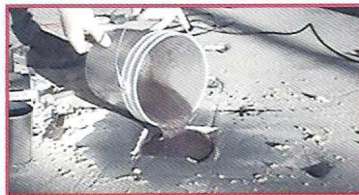
6. Pour into repair area
