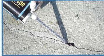
3. Fill Crack
