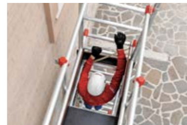
Accesso all'area di lavoro completamente protetta, grazie ai parapetti montati dal basso. Totally safe access to the working area, thanks to the assembly from below of the guard-rail frames.
