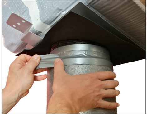
Mit Kaltschrumpfband luftdicht abdichten Kaltschrumpfband ist nicht im Lieferumfang enthalten!
