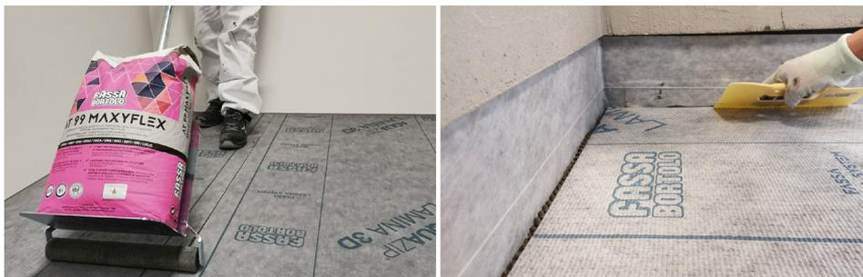
Regolare la quantità di collante in modo da ottenere la corretta bagnatura del telo; un eccesso di adesivo porta alla formazione di increspature e ondulazioni.
