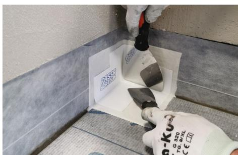
Sigillare quindi tutte le giunzioni tra i teli con la bandella AQUAZIP ELASTOBAND; stendere lo speciale adesivo impermeabilizzante AQUAZIP LAMINA FIX mediante la parte liscia della spatola lungo tutto il perimetro, sia sulla superficie orizzontale sia verticale su una fascia alta circa 10 cm. Stendere l'adesivo impermeabilizzante anche in corrispondenza degli accessori precedentemente installati per circa 5 cm.
