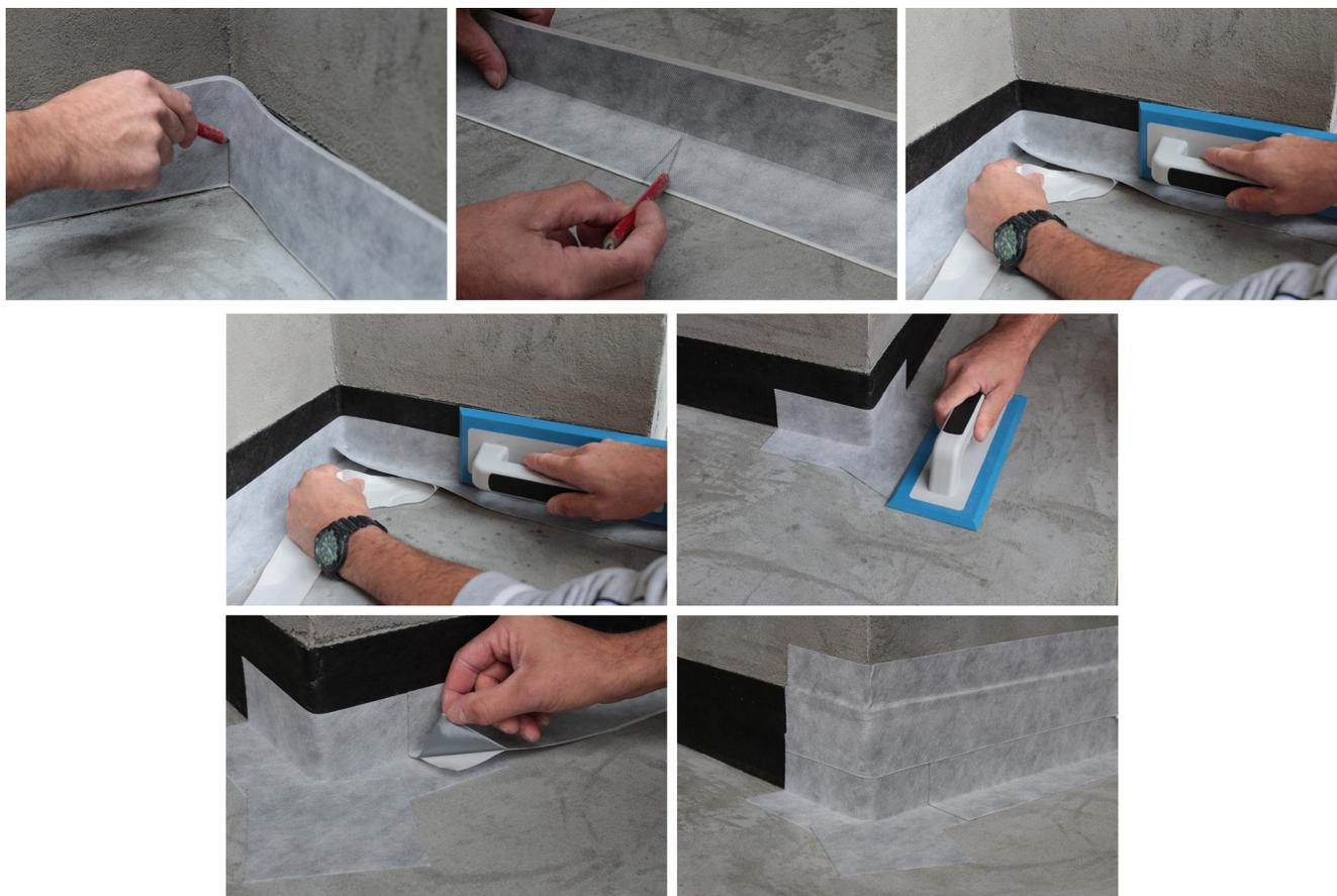
Incollare quindi AQUAZIP LAMINA 3D sulla superficie orizzontale da trattare con l'adesivo prescelto, avendo cura di farlo aderire anche sopra la BANDELLA ADESIVA (lasciare un giunto di 5 mm dalla parete); pressare il telo con un rullo pressa-guaina; accertarsi della completa bagnatura del telo e rimuovere il collante in eccesso.
