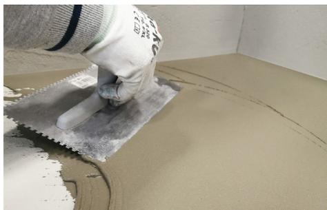
Realizzare le coste con una spatola dentata da 5 mm e successivamente, sul collante fresco, srotolare e stendere immediatamente il foglio di AQUAZIP LAMINA 3D precedentemente preparato, avendo cura di non far coincidere le giunzioni del telo con giunti, fessurazioni o punti critici da trattare presenti sul supporto, ma orientare i vari teli in modo trasversale, accostandoli uno all'altro e distanziandoli di circa 2 mm.
