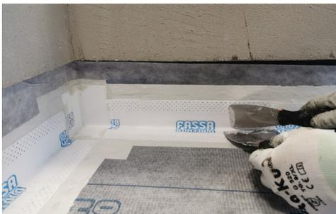
Completare il trattamento di tutti i punti critici applicando AQUAZIP LAMINA FIX sopra all'accessorio AQUAZIP ELASTOBAND per almeno 6 cm, 3 cm sopra all'accessorio e 3 cm sopra alla membrana.
