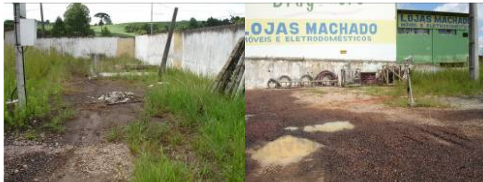
Figura 7. Subestação de Mandirituba
