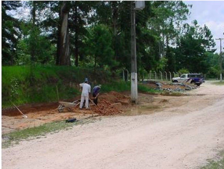
Figura 2. Retirada do solo contaminado.
