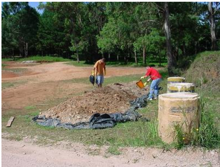
Figura 5. Processo de Remediação das pilhas de tratamento.
