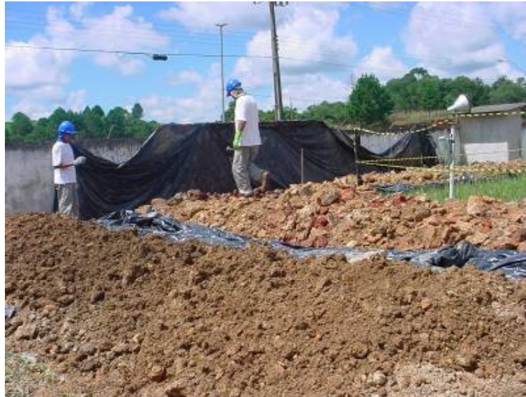
Figura 1. Pilhas de tratamento.
