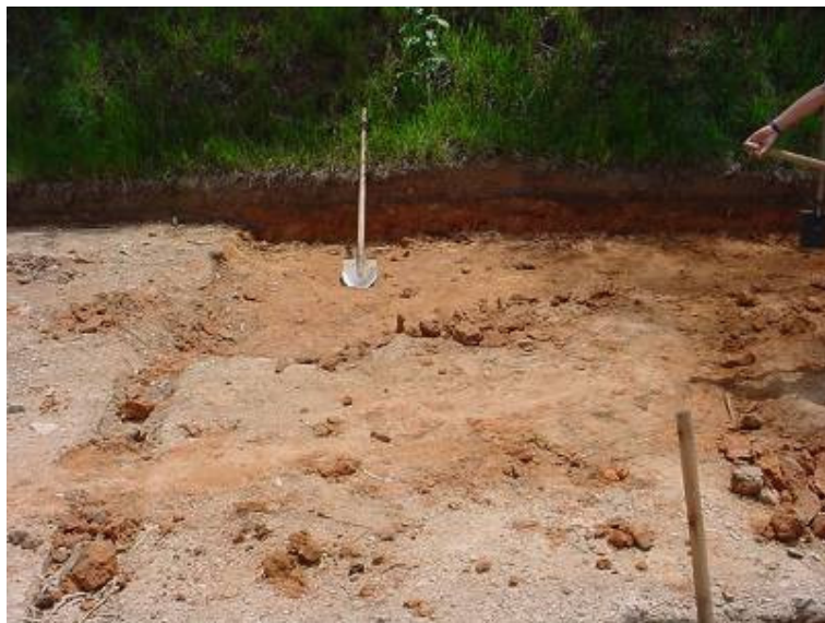
Figura 3. Retirada de mais 20 cm de solo contaminado.
