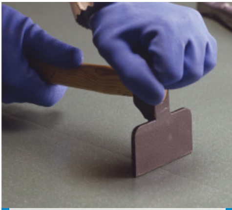
Anreiben des Belages über der Fuge
