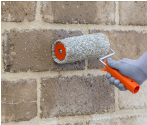
Anwendung von Primer 3296 mit der Rolle auf Tuffsteinmauerwerk
