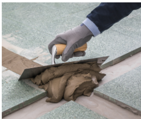
Füllen von Aussparungen mit Planipatch Xtra
