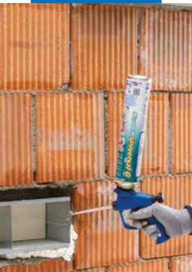
Ausfüllen eines Lüftungskanales
