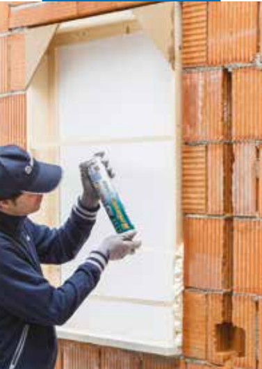
Ausfüllen von Hohlräumen zwischen Fensterrahmen und Wand
