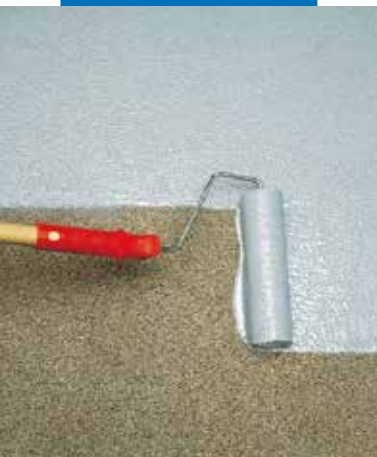
Rollapplikation von Mapecoat I 24
