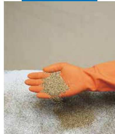
Überschussabsandung mit feuergetrocknetem Quarzsand
