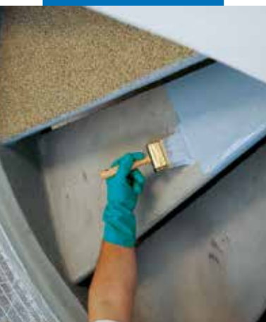
Auftragen der ersten Schicht Mapecoat I 24 mit Pinsel
