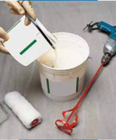
Mischen der Komponente A mit Komponente B
