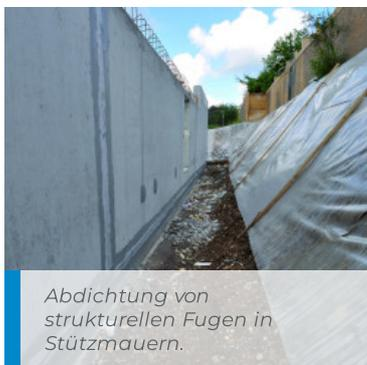
Abdichtung von strukturellen Fugen in Stützmauern.
