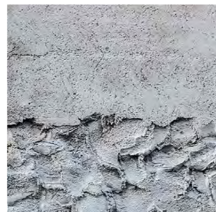
Zweite Putzlage und fertiger Grobputz
