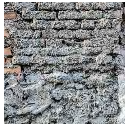
Vorspritzer und erste Putzlage
