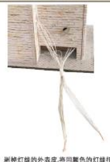
剥掉灯线的外表皮,将同颜色的灯线扭在一起
