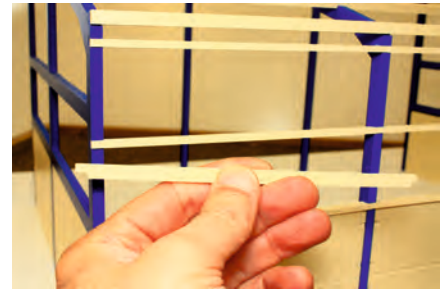
(Wall Cladding Rail)
