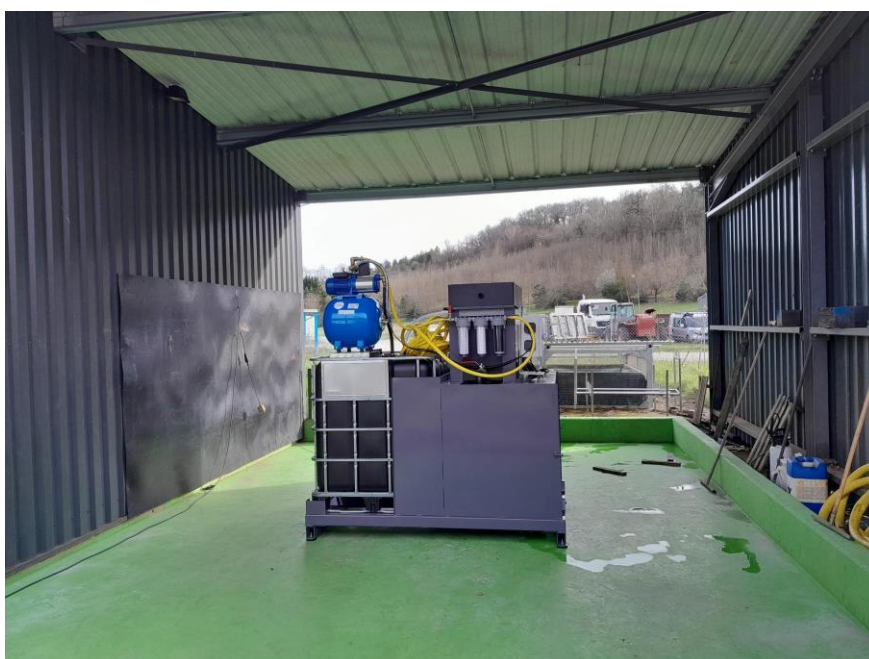
Atlantik1® sur aire bétonnée
