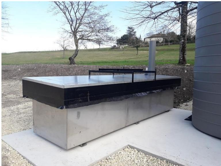
Dispositif de traitement des effluents phytosanitaires conçu pour gérer des volumes plus élevés d'effluents. Selon la version choisie, il permet le stockage de 2000 à 6000 litres d'effluents. Le couvercle particulier de la cuve a été breveté par VENTO-SOL. La cuve a été conçue pour optimiser la surface d'échange entre l'air et l'effluent.
