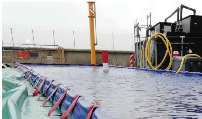
Bâche remplie avec équerres relevées.
