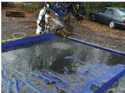
Opérations de lavage sur bâche souple les effluents sont retenus.
