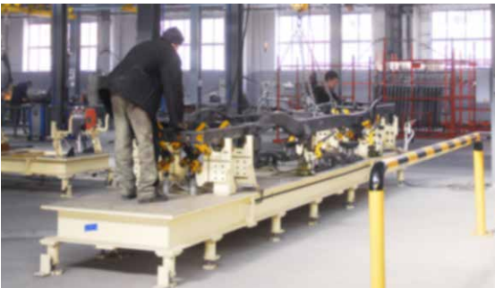
Instalación de maquinaria
