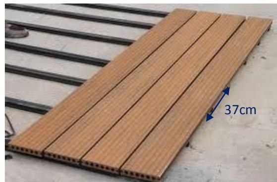
Esa medida permite instalar 6 fijaciones por tabla imprescindibles para que el deck tenga un óptimo y seguro anclaje.
