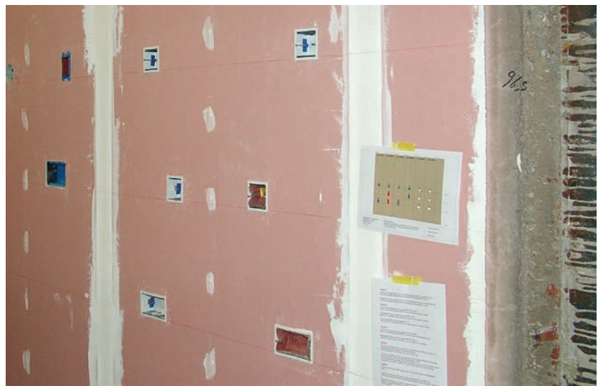
EN FIRE TEST AT EFECTIS, HOLLAND
