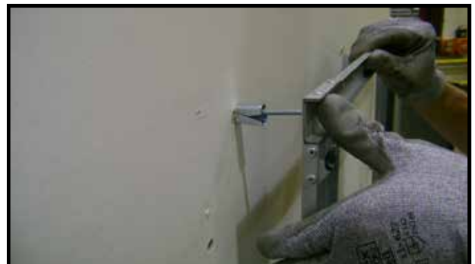
Figure 4.6 Installation des ancrages dans une cloison creuse
