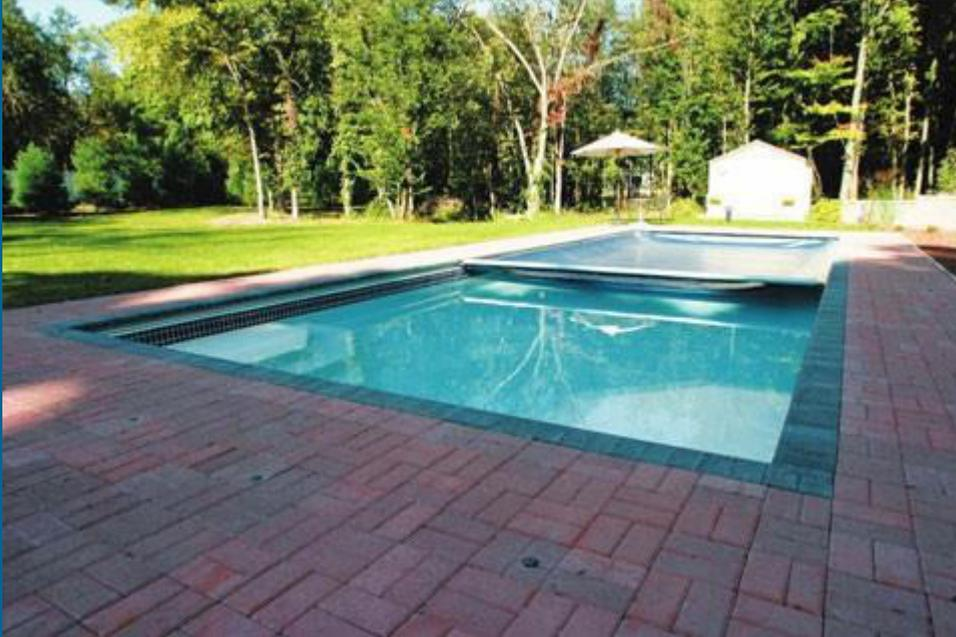
Encapsulado ( en muro # 4 ) es diseñado para instalaciones de piscinas de fibra de vidrio. Aquamatic tiene 6 extrusiones para adaptar a su criterio
