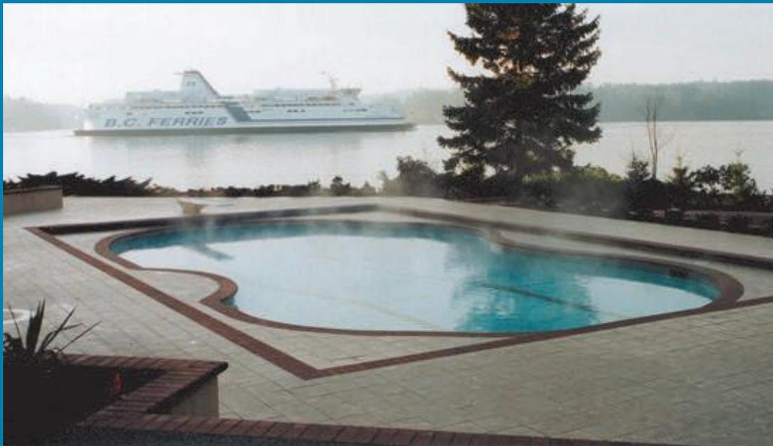
Una Piscina dentro de una Piscina es una técnica de diseño usada cuando se desea una piscina de forma libre sin usar rieles montados sobre la superficie. Un rectángulo levantado con escalones se construye fuera de la máxima anchura y longitud creando un marco alrededor de la piscina. El uso de rieles encapsulados en muro son recomendados para este tipo de instalación.
