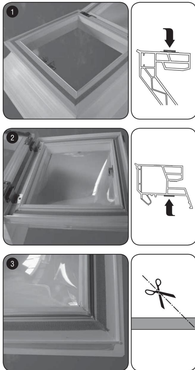
**1** Dégraissez la bride de la costière avec du thinner. Fixez la bande crochet à la zone rainurée de la bride de costière. Le côté charnière doit resté dégagé de sorte que la face frontale et les deux faces latérales soient prévues de toile moustiquaire.
