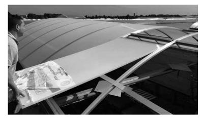
Fixez la plaque avec le profil d'emboîtement (LPO25) sur le profil longitudinal (LP625 ou LP125).
