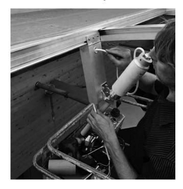
Poussez le câble d'alimentation situé de l'autre côté dans la gaine et procédez au raccordement électrique dans la gaine dans une prise de raccordement (non fournie) ou utilisez une autre méthode de raccordement.
