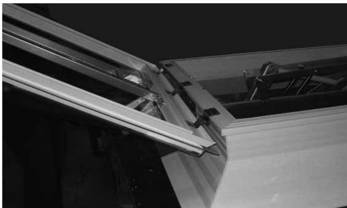
Schließen Sie die Kuppel und montieren Sie die Scharnierachsen (1 pro Scharnier).
