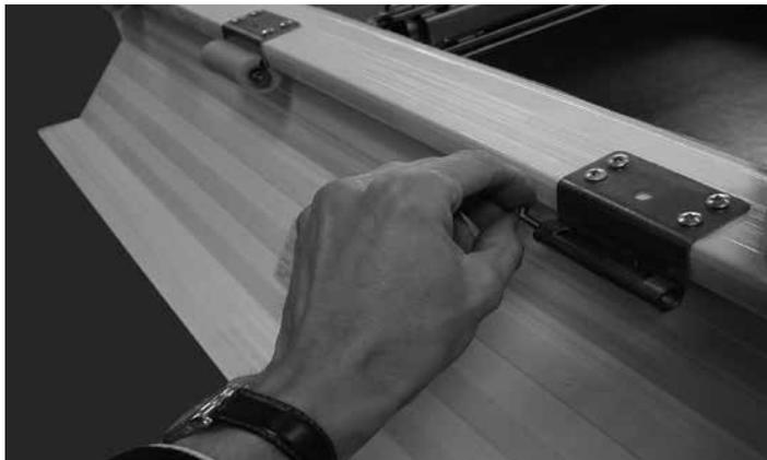
Stellen Sie die Kuppel 140°-160° dem Aufsatzkranz gegenüber damit die Kuppelscharniere in den Aufsatzkranzscharnieren einhaken.
