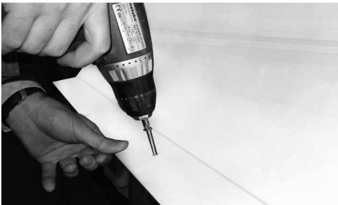
Wenn die Dachausstiegskuppel montiert ist, muss man überprüfen, ob der Öffnungswinkelbegrenzer richtig montiert ist. Der Öffnungswinkelbegrenzer muss auf einen maximalen Öffnungswinkel von 90° eingestellt werden. Öffnen und schließen Sie das System 10 Mal und prüfen Sie, ob der Begrenzer am Platz bleibt. Bitte beachten Sie, dass bei einem Winkel von 75° der Massenschwerpunkt der Klappe über die Scharniere geht und die Klappe kippen kann, wenn der Begrenzer nicht richtig montiert ist.
