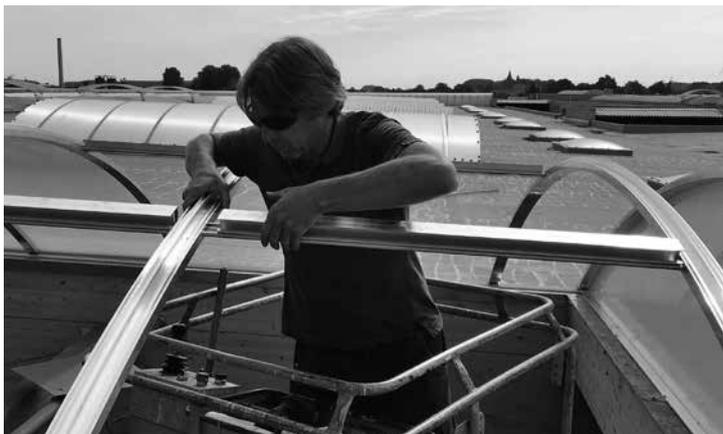
Die 4 Traversen mit 4 M6 x 70 mm Bolzen befestigen.
