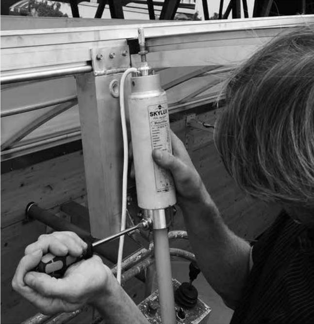
Stecken Sie das Motorkabel ins Rohr.
