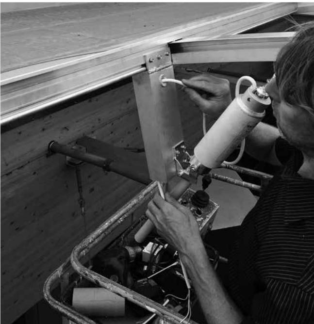
Stecken Sie das Stromkabel an der anderen Seite ins Rohr und machen Sie den elektrischen Anschluss im Rohr in einem Verbindungskasten (nicht mitgeliefert) oder verwenden Sie eine andere Anschlussmethode.
