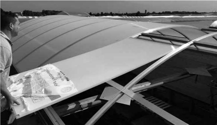
Befestigen Sie die Platte mit Abschlussprofil (LP025) am Längsprofil (LP625 oder LP125).
