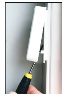
Imagen: Desmontaje de la tapa de un sensor o imán
