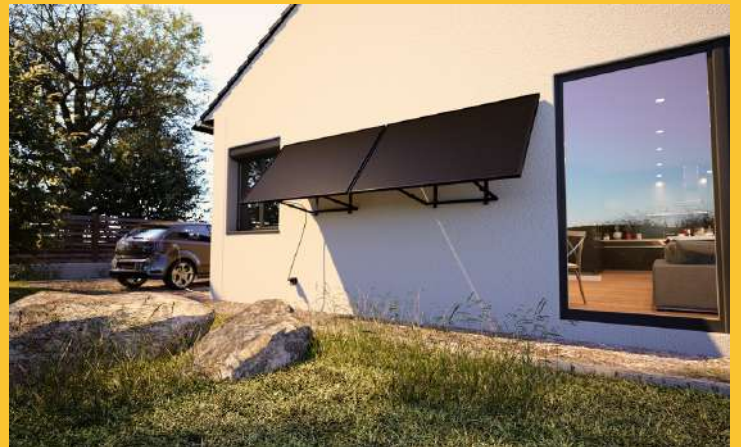
Mur - Façade - Pignon
